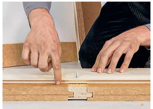
**Die Randdämmstreifen aus Holzfaser sorgen für die Entkopplung des Schalls zur Wand und für den Randabstand.**
