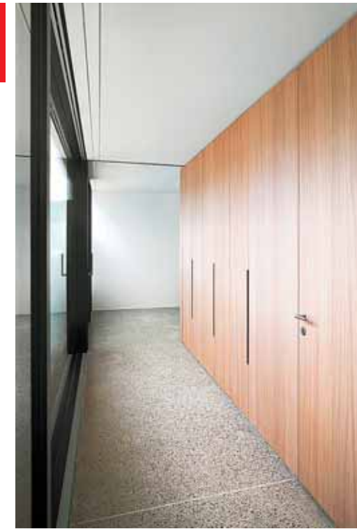
Einen fast rohen Charakter erhält das streifige Eichenfurnier durch das weißpigmentierte Öl. Warm in der Anmutung und doch zurückhaltend im Auftritt schafft das Holz architektonisch wirksame Bereiche im Haus (Fotos: Valentin Jeck)
